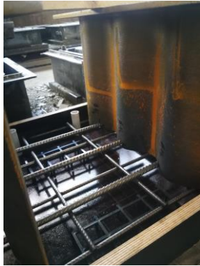
Abb.7: Stahlträger mit durchgesteckten Querstäben als Verbinder
