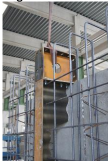
Abb.10: Detail obere Rahmenecke vor Montage der dünnwandigen Platten
