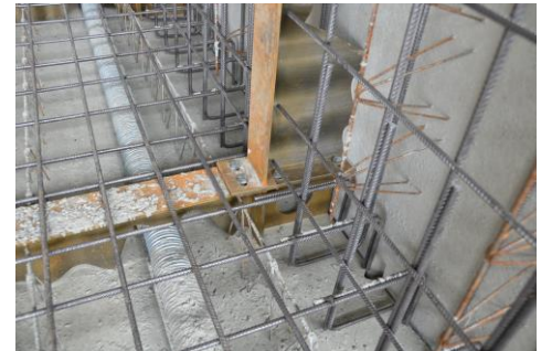
Abb.12: Detail untere Rahmenecke nach Zusammenbau des Segments
