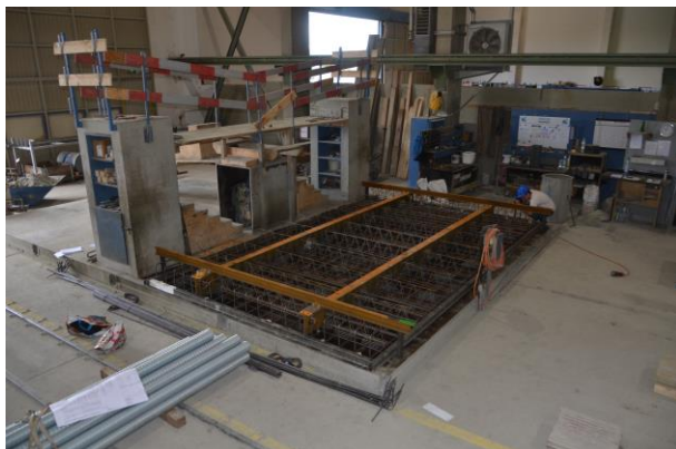
Abb.13: Bewehrungskorb einer Platte mit eingelegten T-förmigen Stahlträgern
