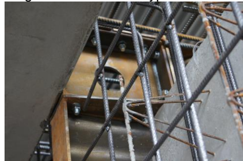
Abb.11: Detail obere Rahmenecke nach Montage der dünnwandigen Platten
