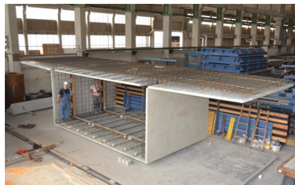
Abb.16: Prototyp nach Fertigstellung aller Arbeiten
